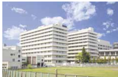
⑭ ⑮ 医学部附属病院第一病棟及び第二病棟
