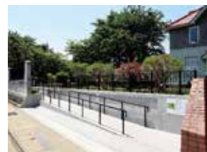
アプローチ用スロープ
