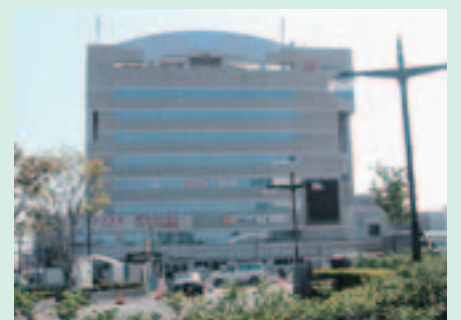
八戸サテライトが入居するJR八戸駅東口の「ユートリー」(八戸地域地産産業振興センター)
