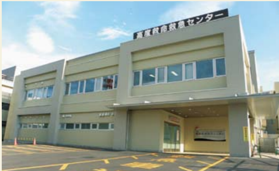
医学部附属病院高度救命救急センター。
