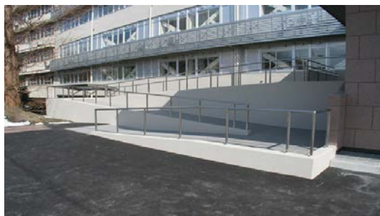
総合研究棟(臨床医学系)正面玄関脇のスロープ
