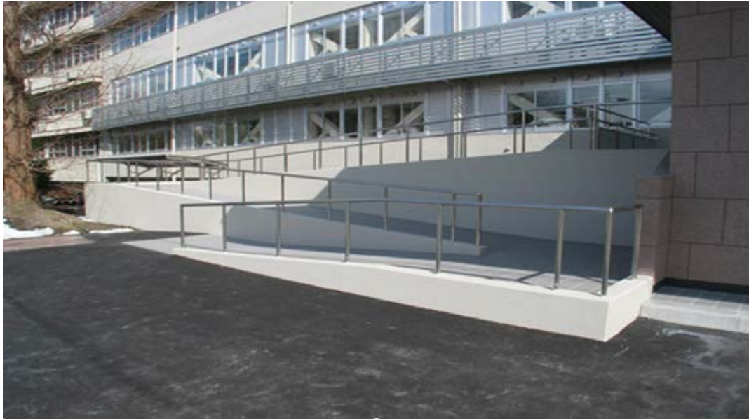
臨床研究棟正面玄関脇のスロープ
