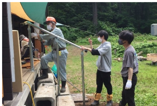
デッキ階段の手すりの調整
