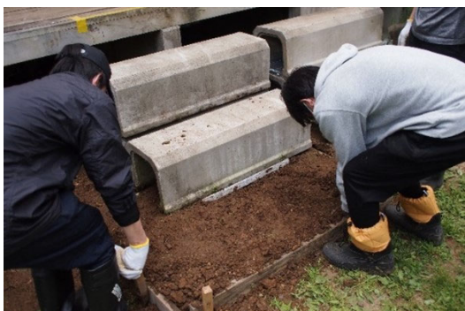
デッキ階段のU字溝と基礎土の敷設
