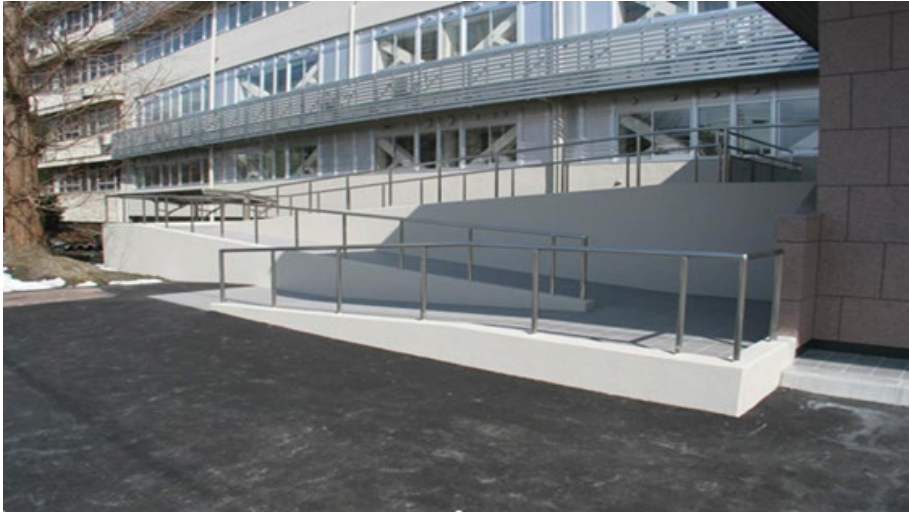
臨床研究棟正面玄関脇のスロープ
