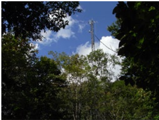
白神フラックスタワー (全高34m： 鱒ヶ沢町)
