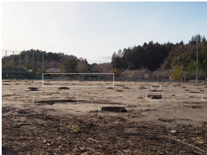
写真5 (図2-P5) 野球場一塁側から三塁側方向. 実線囲みにみられるフェンスは写真4の実線部分(一塁側)に設置されており, 三塁側まで流されていた. また破線囲みにみられる複数のブロックは写真4の破線部分から削り出され野球場全体に散乱していた.
